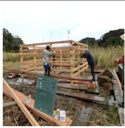
生簀組立作業
