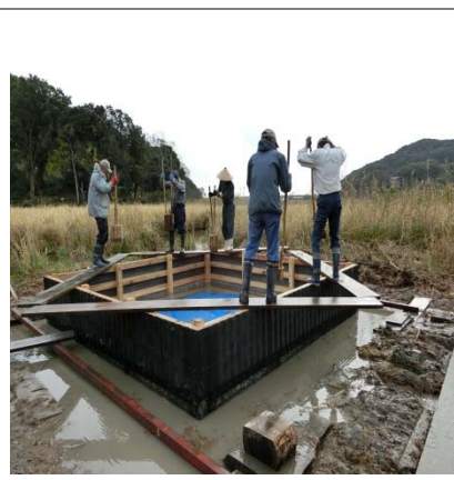
埋設作業(打ち込み固定)
