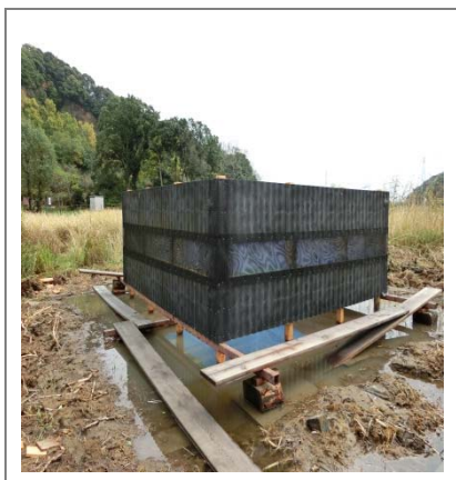
生簀組立完了(中央は通水路)
