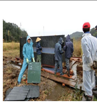
柵板取り付 (内側ネット張り)
